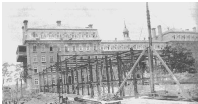
L'aile des Anciens en construction, rue Mgr-Gosselin
