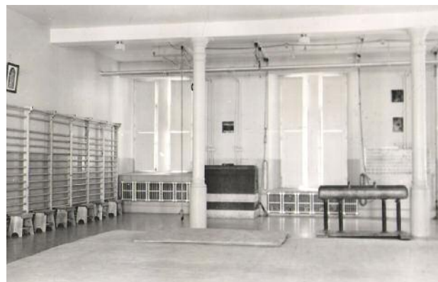
Le gymnase sous la chapelle
