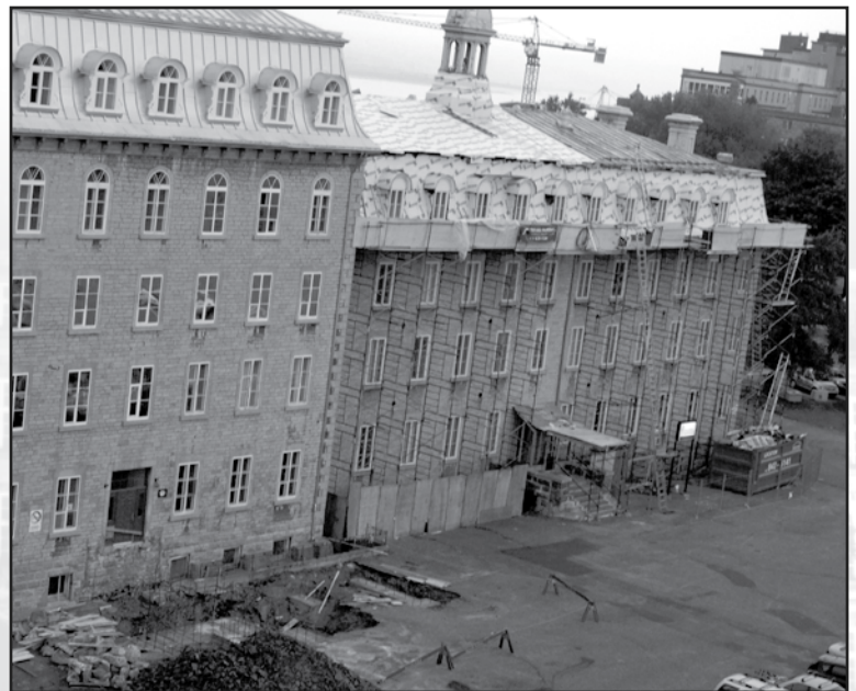
Vue partielle des travaux Toiture et perron
